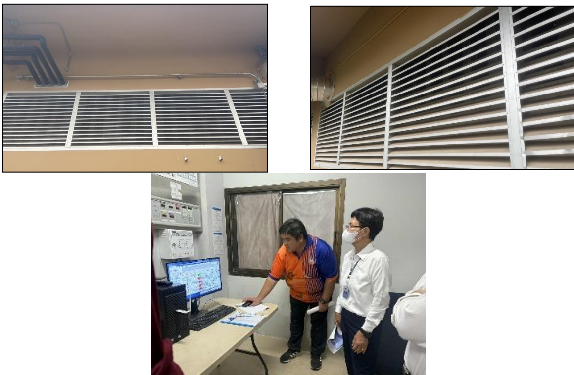
รูปที่ 2.2-15 ประตुरบายอากาศ และพัดลมดูดอากาศภายในห้องเครื่องกำเนิดไฟฟ้า
