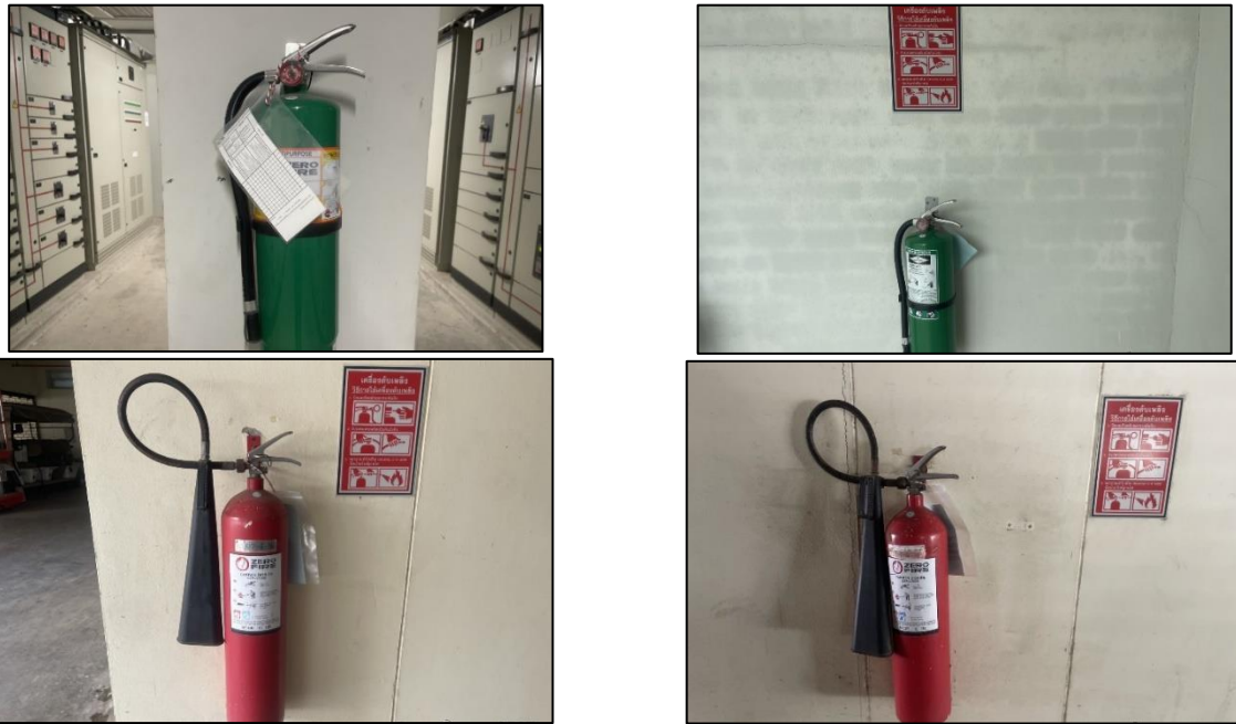
รูปที่ 2.2-36 ถังดับเพลิงเคมีชนิดมือถือ
