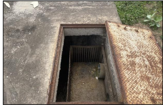
รูปที่ 2.2-21 ตะแกรงดักขยะของระบบบำบัดน้ำเสีย
