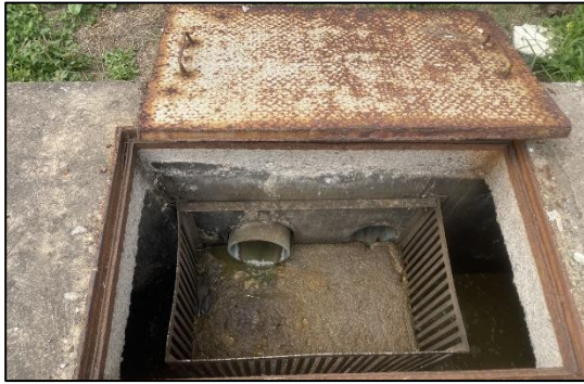
รูปที่ 2.2-21 ตะแกรงดักขยะของระบบบำบัดน้ำเสีย
