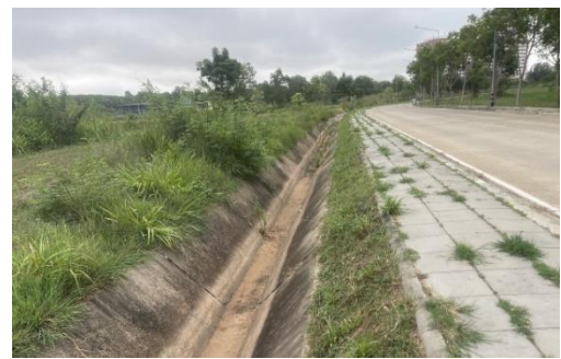
รูปที่ 2.2-22 รางระบายน้ำฝนของโครงการ
