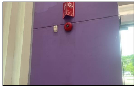
รูปที่ 2.2-33 ระบบสัญญาณเตือนเพลิงไหม้โดยมือ กริ่งสัญญาณเตือนไฟไหม้
