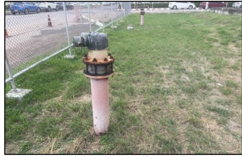
รูปที่ 2.2-38 หัวรับน้ำดับเพลิงจากภายนอกที่ชั้น 1
